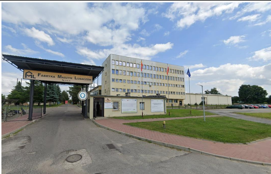
Zdjęcie 13. Fabryka Maszyn Lubaczów – widok z ul. Mazury
