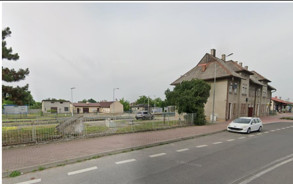
Zdjęcie 3. Stacja kolejowa Lubaczów
