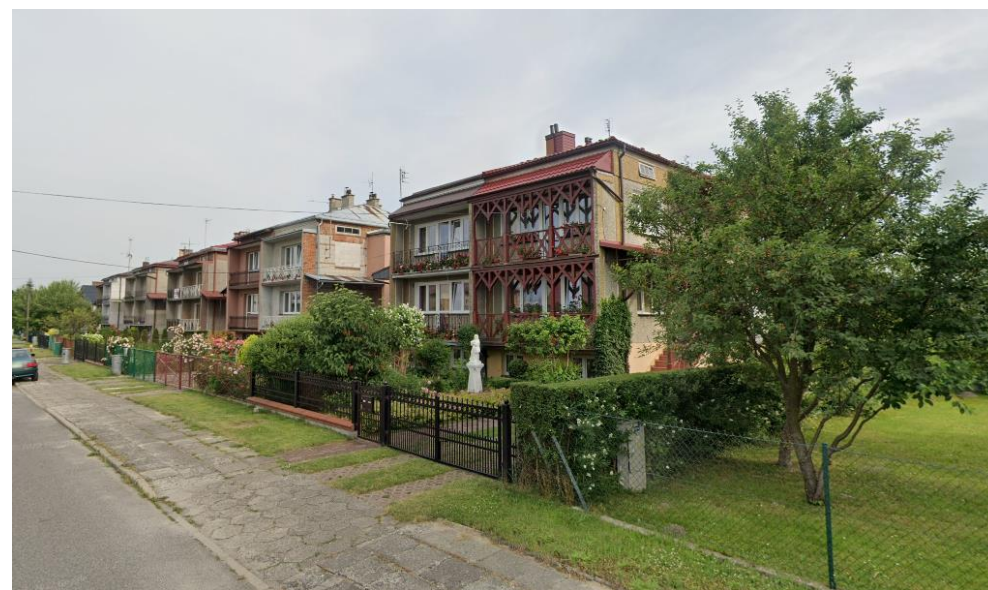
Zdjęcie 4. Zabudowa mieszkaniowa jednorodzinna przy ul. Westerplatte
