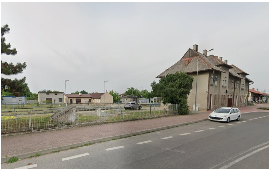
Zdjęcie 3. Stacja kolejowa Lubaczów
