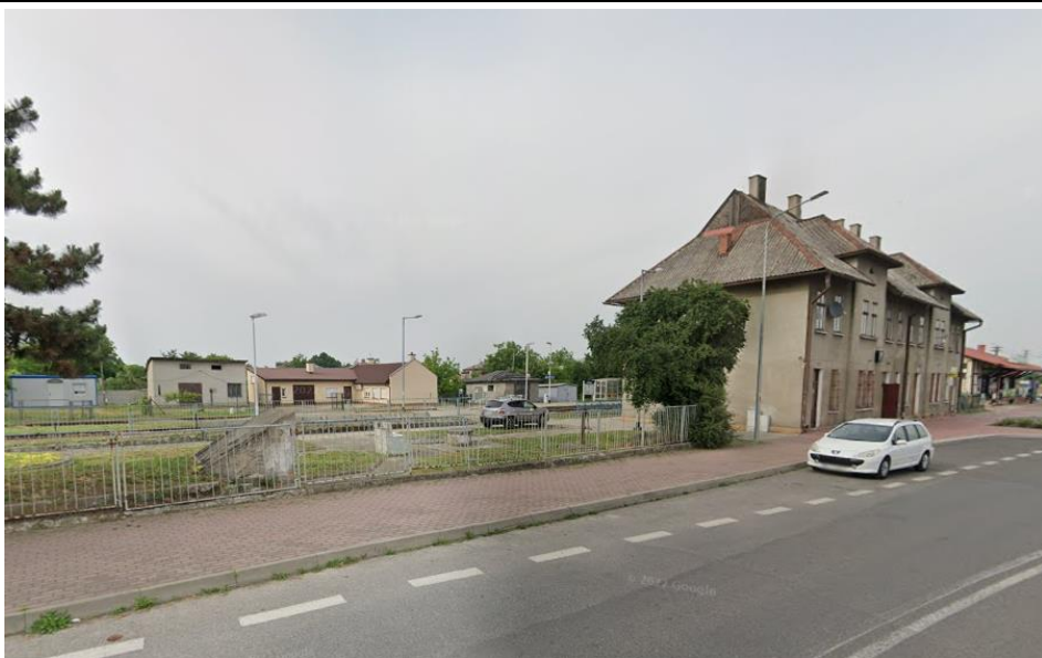
Zdjęcie 3. Stacja kolejowa Lubaczów
